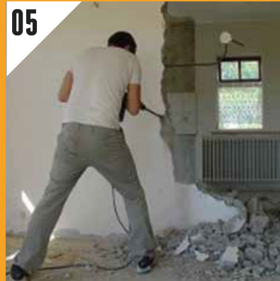
住宅拆卸工程 Residential Demolition
