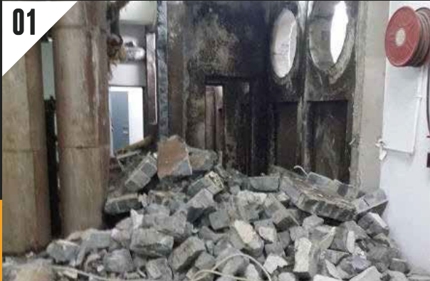
餐廳清拆及還原工程 + 打拆工程 Restaurant Demolition
